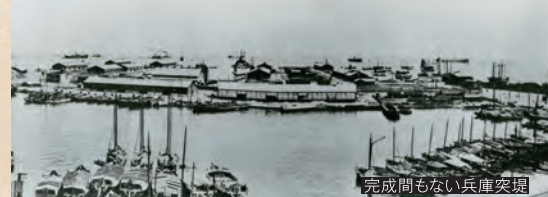
完成間もない兵庫突堤
